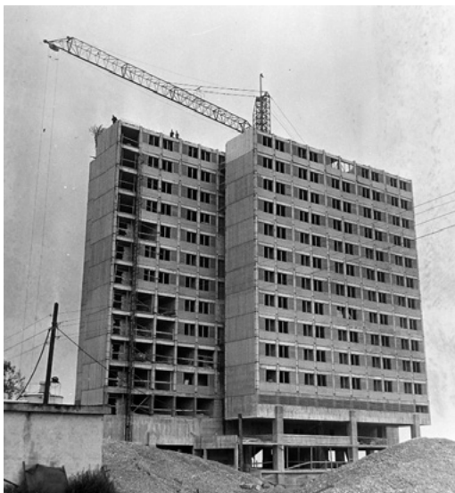
1. kép: A Hotel Marina építése, Balatonfüred, 1968 Figure 1: Construction of the Hotel Marina, Balatonfüred, 1968
